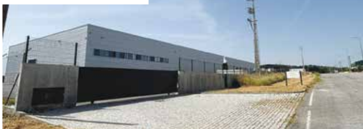
A Câmara Municipal investe na ampliação da Zona Industrial com a aquisição de novos terrenos
