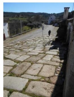
**Figura 75** - Pavimento em lajetas de granito
