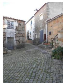
**Figura 72** - Pavimento em cubo de granito
