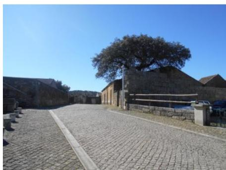
**Figura 71** - Pavimento em cubo de granito
