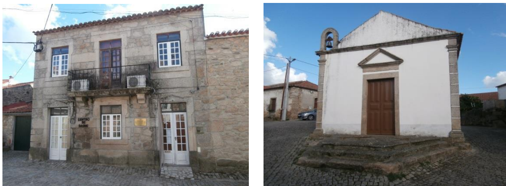
Figura 5 – Centro de Saúde e Capela de São Sebastião de Medelim
