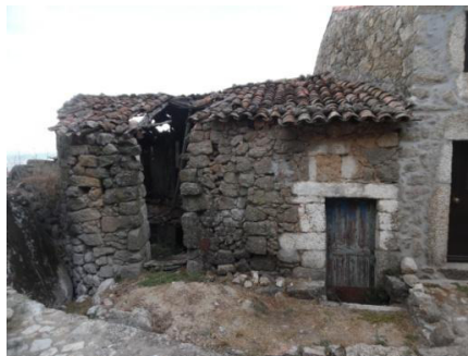
Figura 27 - Rua da Atafona
