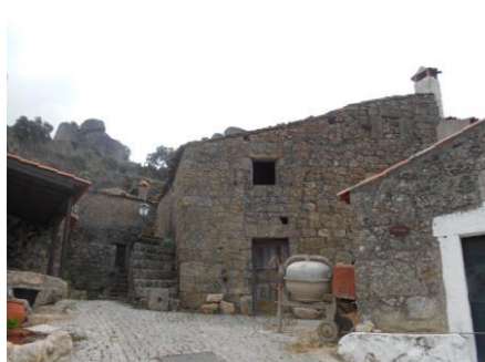
Figura 26 - Rua da Barreira Quebrada
