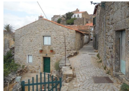
Figura 36 - 2 no logradouro e 1 piso na Rua da Barreira Quebrada
