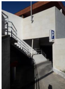
B Figura 144 - Interior do Edifício multifunções
