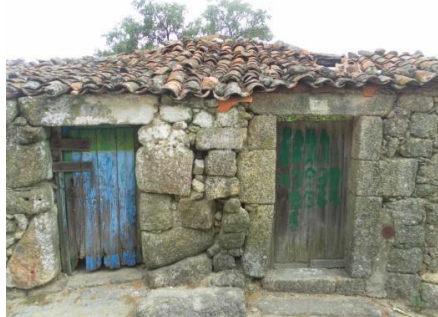
Figura 21 - Rua do Castelo
