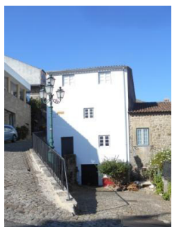
Figura 37 - Rua Fernando Namora com Rua da Capela
