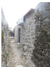
Figura 122 - Rua da Atafona
