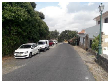
1 Figura 146 - Rua Fernando Ramos Rocha
