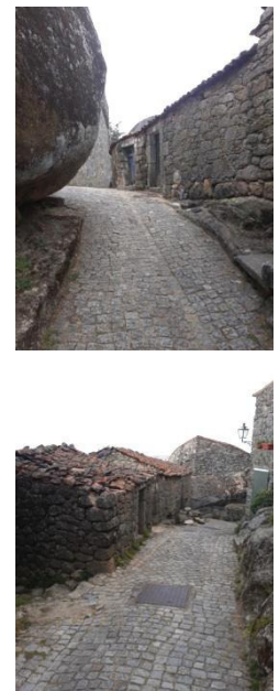
Figura 13 - Rua do Castelo
