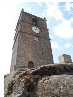
Figura 40 - Torre de Lucano
