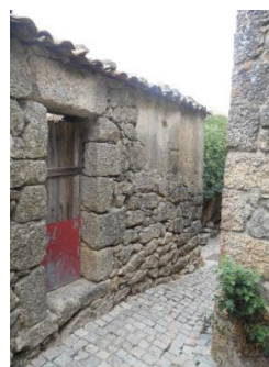
Figura 25 - Rua da Barreira Quebrada
