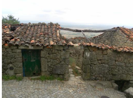
Figura 22 - Rua do Castelo
